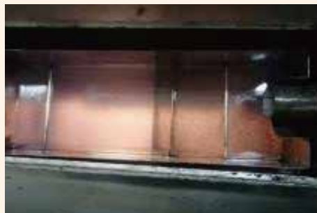
汚物（油）が除去されている
